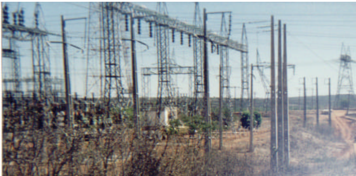
Foto – 1D1: Estruturas da LT 138kV (operando em 69kV) 03C2 B. Nome – Cabrobó (CELPE), a remanejar na saída de Bom Nome.
