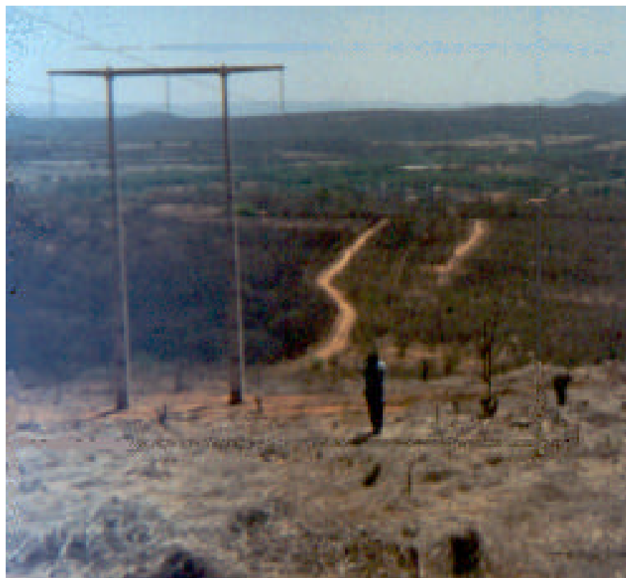
Foto – 1D1: Estruturas da LT 138kV (operando em 69kV) 03C2 B. Nome – Cabrobó (CELPE), a remanejar na saída de Bom Nome.
