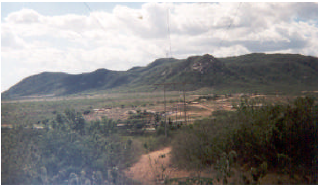
Foto - 1D4: Chegada da LT 138 kV em Salgueiro, cruzando RFFSA e BR-116. Eixo da LT230 kV em estudo à esquerda, tangente V10 – V11.
